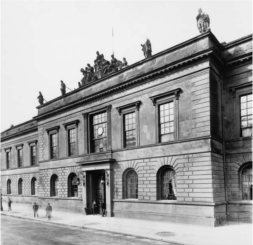
Das Akademie-Gebäude Unter den Linden · 1902
